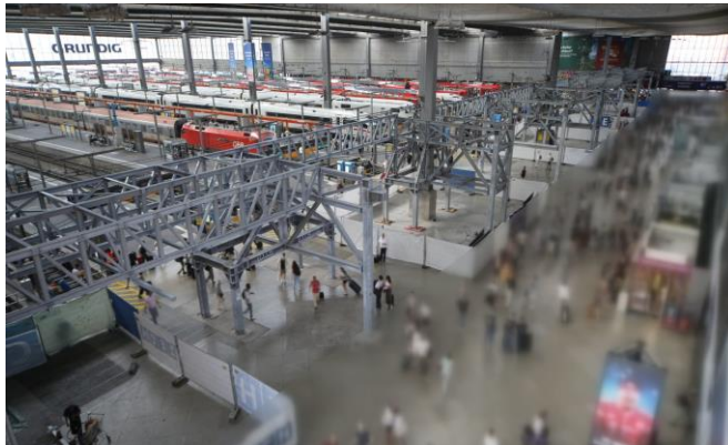
Hauptbahnhof Gerüstaufbau Querbahnsteig für Abbruch MAN-Dach
